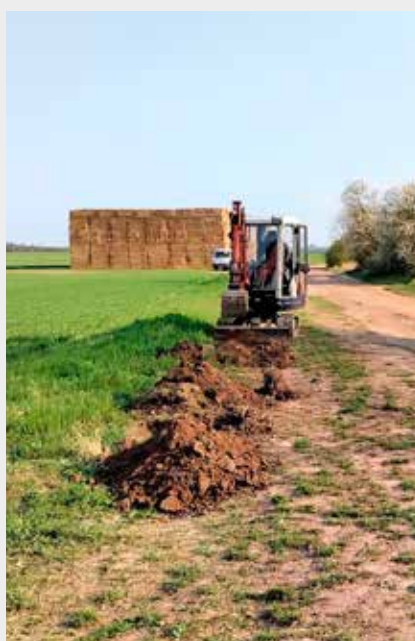
→ Cesta je vytyčena, můžeme začít kopat. Pan Richtr pracoval až do pozdního večera tak, aby se mohlo druhý den začít.
